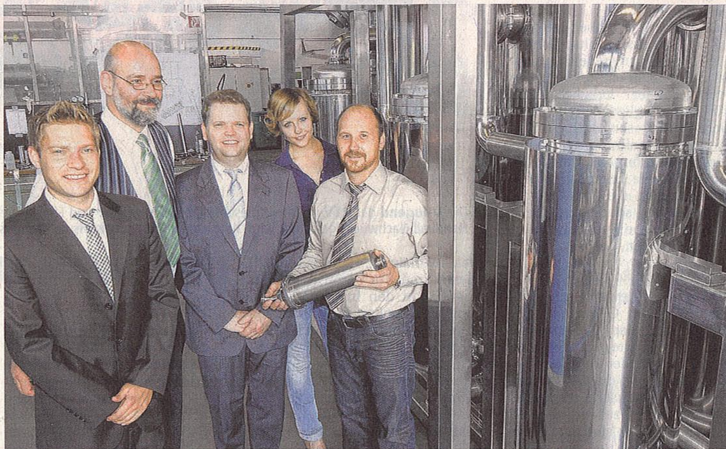
Sind stolz auf die bislang größte Wasseraufbereitungsanlage der Firma GFA Steriltechnik (v. l.): Thomas Rücker , Axel Zimmerbeutel , Jörg Gabriel , Meike Zimmerbeutel und Witali Wiebe . BM-FOTO: NICO HERTGEN
